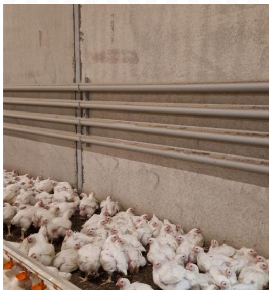
Grzejniki z obiegiem ciepłej wody zapewniają kurczętom zawsze odpowiednią temperaturę w czasie odchovu
